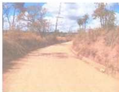
Foto 10 – Limpeza de capina em todo o trecho
