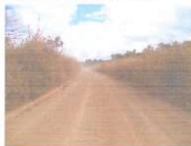
Foto 12 – Limpeza de capina em todo o trecho
