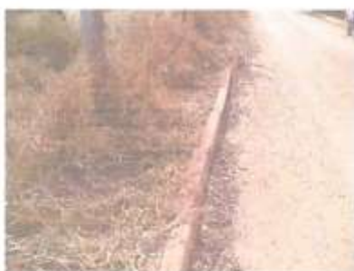
Foto 7 - Sarjeta seria executada no final da obra
