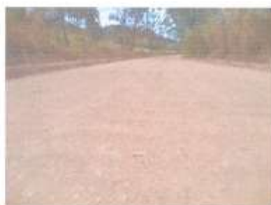
Foto 7 – Sarjeta seria executada no final da obra
