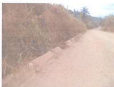
Foto 12 – Limpeza de capins em todo o trecho
