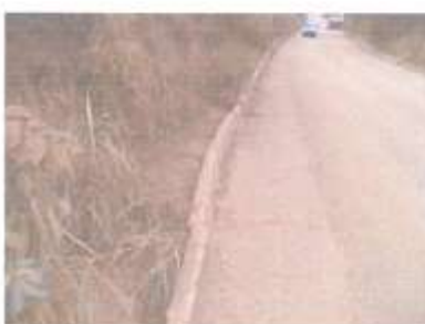
Foto 8 – Sarjeta/Escoramento seria executada no final da obra
