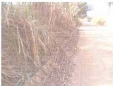
Foto 11 – Limpeza de capina
