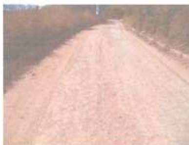
Foto 2 – Base da via de rolagem
