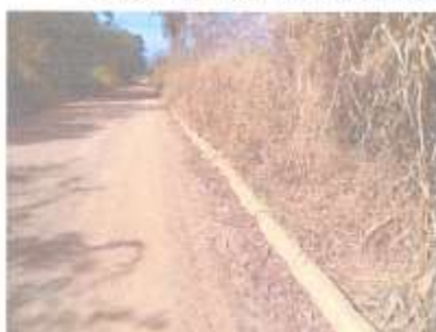
Foto 7 – Sarjeta seria executada no final da obra
