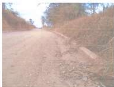
Foto 2 – Base da via de rolagem
